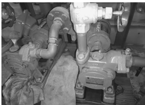
▲給油設備（オイルポンプ2台）
