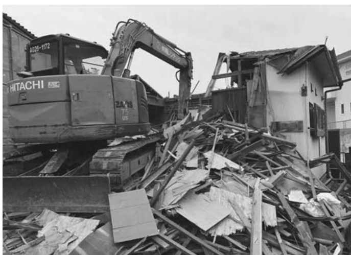
▶空き家解体（イメージ画像）
