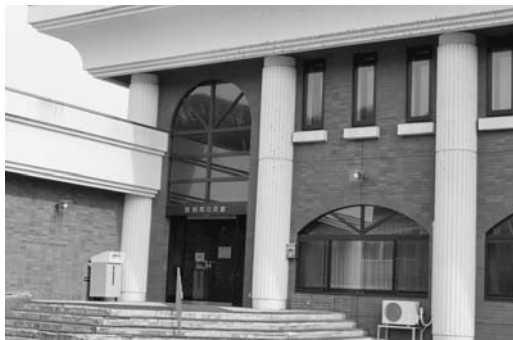
▲ 建築から44年が経過した公民館
