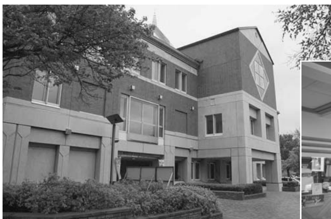
▲ 役場庁舎照明をLEDに改修
