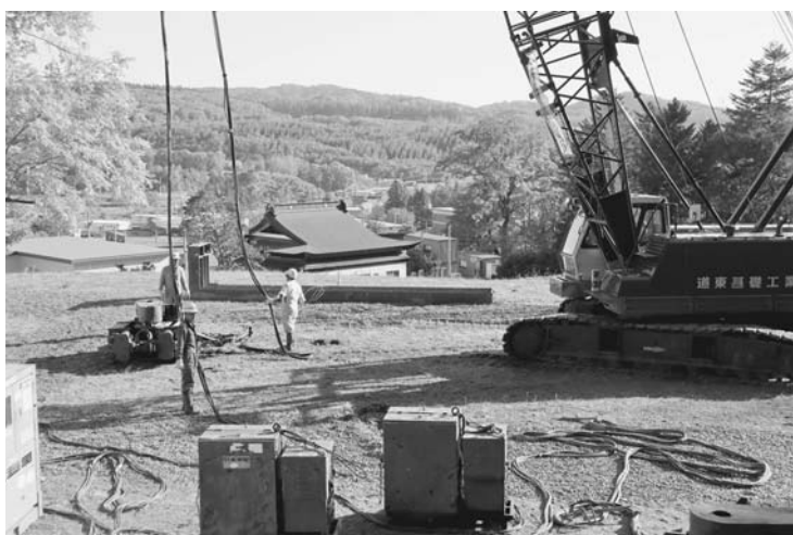
▲ 町発注の合同墓建設工事現場
