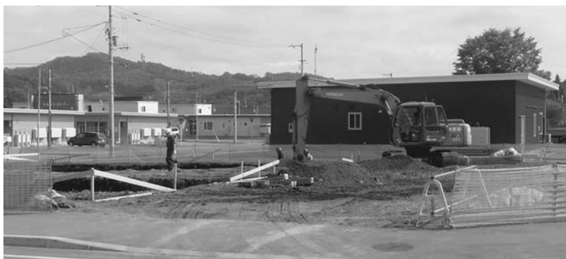
▲ 新町交流館の裏側に公営住宅を建設
