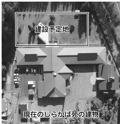
▶ 現施設の裏側に建設予定
