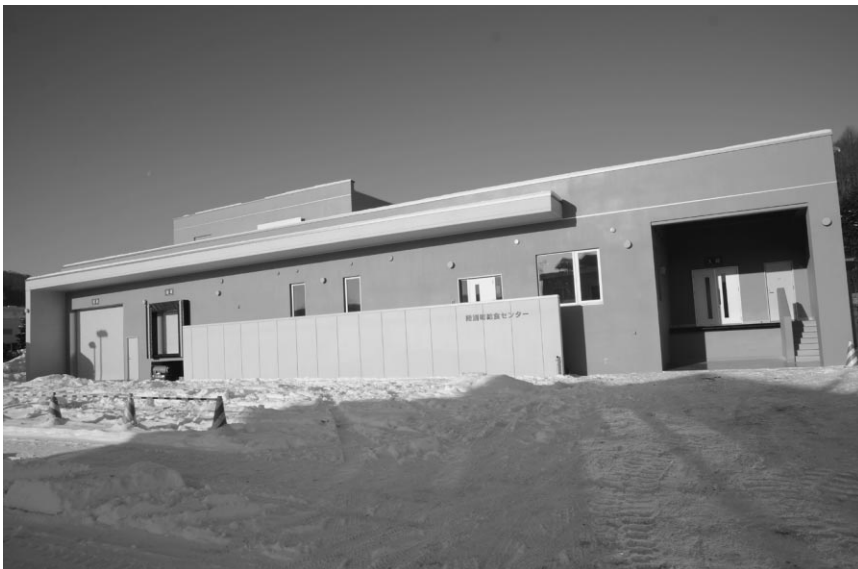
新町2区に建設していた給食センターが2月13日に竣工しました。
