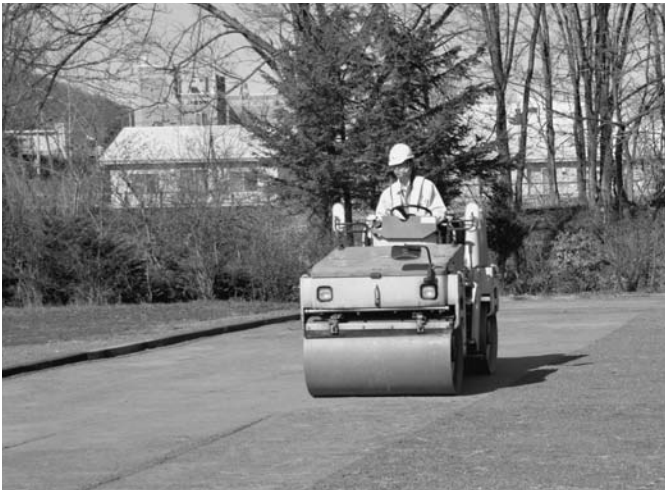
5/10 陸別建設業協会（朝倉昭雄会長）が社会貢献活動の一環として毎年実施している町民テニスコート（下陸別）とゲートボール場（旭町）の整地作業を行い、荒れた路面にローラーをかけました。
