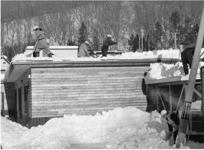
1/18 町内で工事を行っている榊平田建設（土幌町：野中 栄忠 代表取締役）は、地域貢献活動の一環として、「からまつハウス」の屋根の雪下ろしや「福寿荘」敷地内の排雪作業を行いました。
