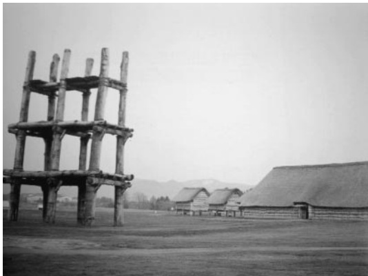
写真② 復原された掘建柱建物、大型竪穴住居等
