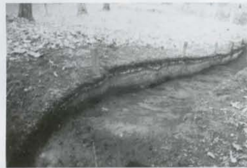
写真② C郭の周りの盛土の断面
