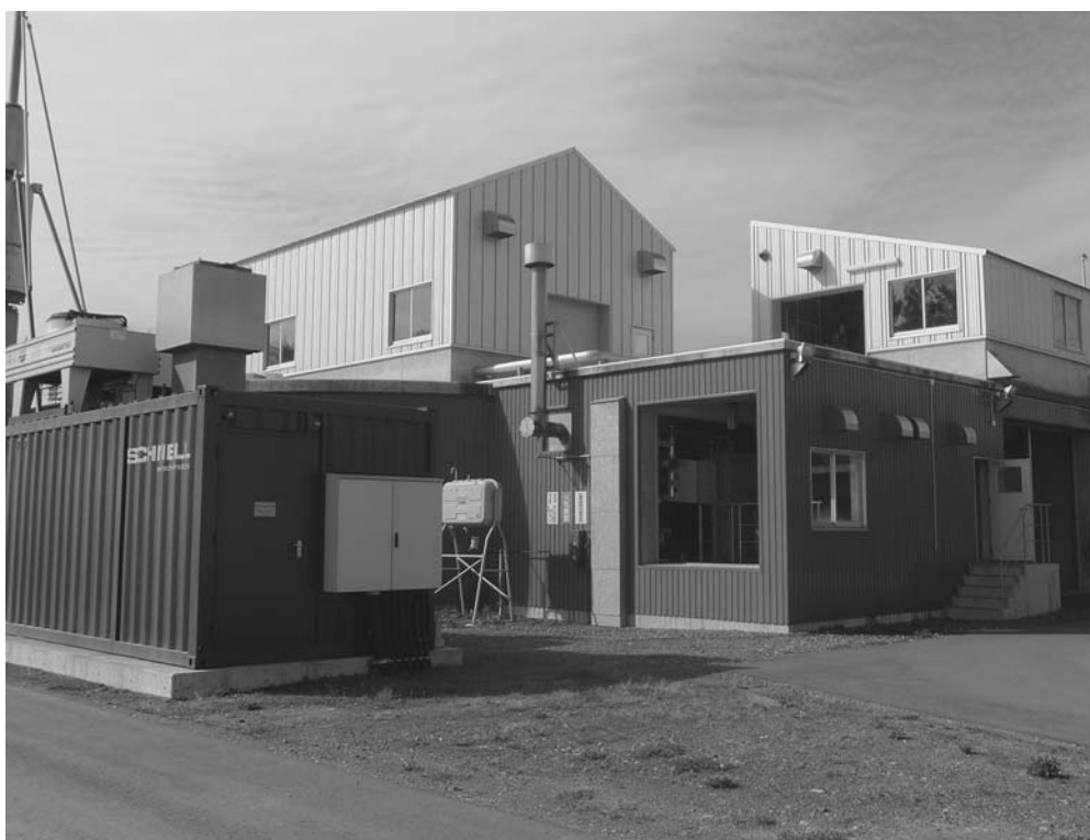
▲ 興部北興バイオガスプラント
