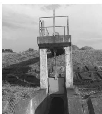
▶ 陸別川に設置されている樋門
