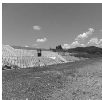
▲ 完成した利別川の堤防
