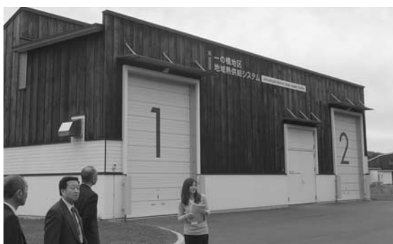
▶一の橋地区の木質バイオマスボイラー施設
