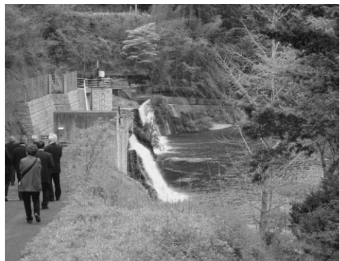
*わずかな落差を利用した小水力発電所
