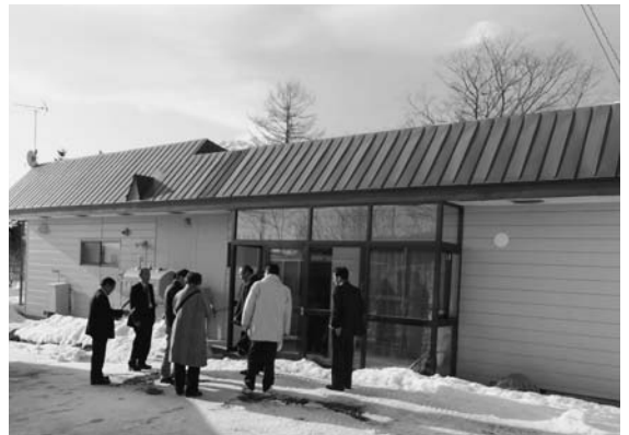
改修された恩根内の住宅
