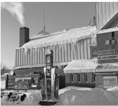
▲ 屋根からの落雪に注意 (道の駅)
