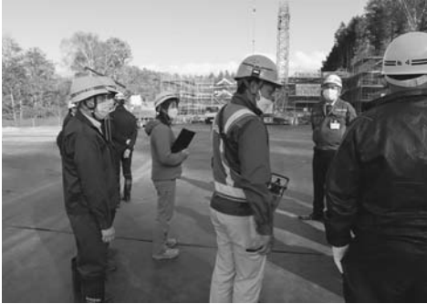
▲ オホーツク自動車道の建設現場
