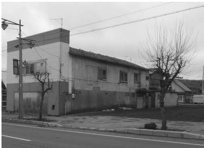
▶平成29年に寄附を受け解体される旧鹿野水産
