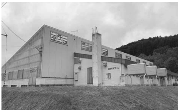
▲ 昭和57年に建設された町民プール
