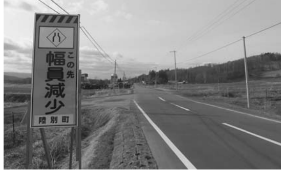
▲ 工事が進む町道関北一線連絡線
