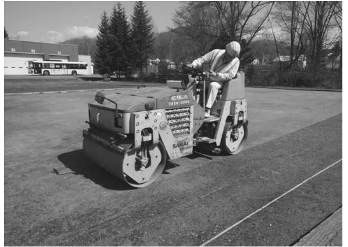
4/21 陸別建設業協会（松浦泰仁会長）が社会貢献活動の一環として、町民テニスコート（下陸別）とゲートボール場（旭町）の整地作業を行いました。この活動は毎年実施しているもので、雪解け後の荒れたコートを作業車で丁寧に転圧しました。
