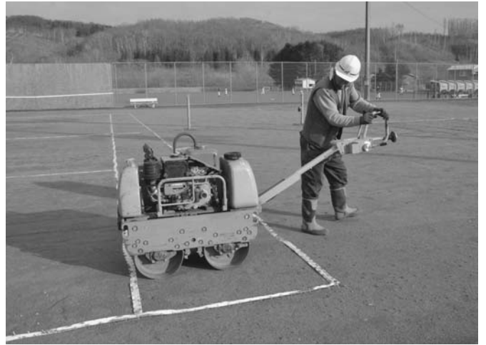
4/26・27 陸別建設業協会（松浦泰仁会長）が社会貢献活動の一環として、町民テニスコート（下陸別）とゲートボール場（旭町）の整地作業を行いました。この活動は毎年実施しているもので、雪解け後の荒れたコート丁寧に転圧しました。
