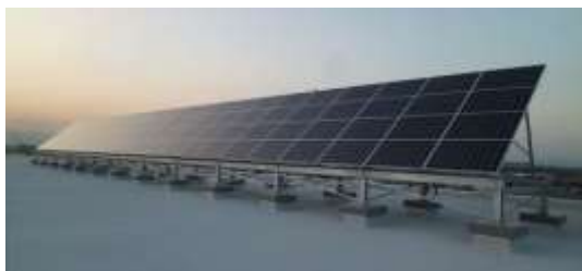
公共施設への太陽光パネルの設置
